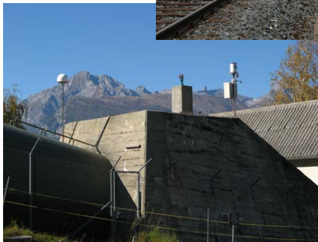
Überwachung von Druckleitungen in geologisch nicht stabilem Untergrund
